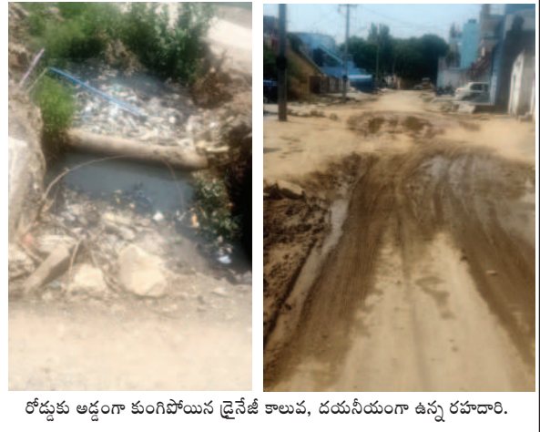
రోడ్డుకు అడ్డంగా కుంగిపోయిన డ్రైనేజీ కాలువ, దయనీయంగా ఉన్న రహదారి.
